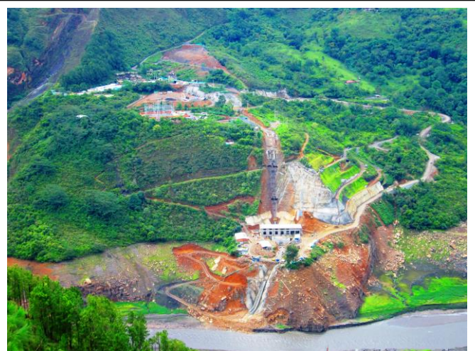
Figura. 2. PCH Tunjita en Construcción 2014. Foto: AES CHIVOR
