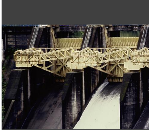
Ilustración 4. Central hidroeléctrica alto Anchicaya. La presa tiene una capacidad de almacenamiento de 45 millones m 3 de agua y una capacidad instalada de 340 MW. Fuente: CELSIA
